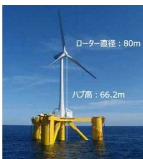
2MW 風力発電風車「ふくしま未来」
