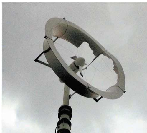
写真6-4 強風で破損した福岡市に設置された風レンズ風車
