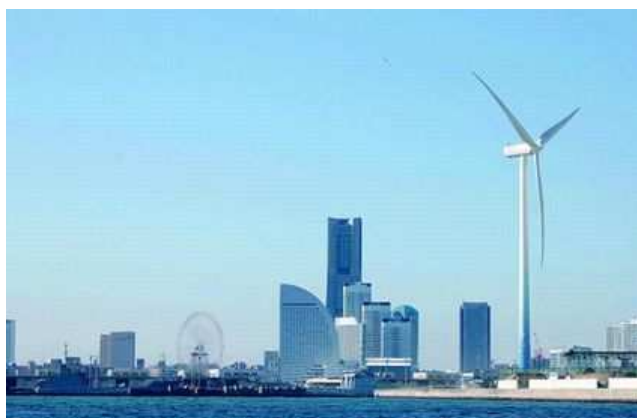
写真 5-1 定格出力2MWの風力発電「ハマウイング」
