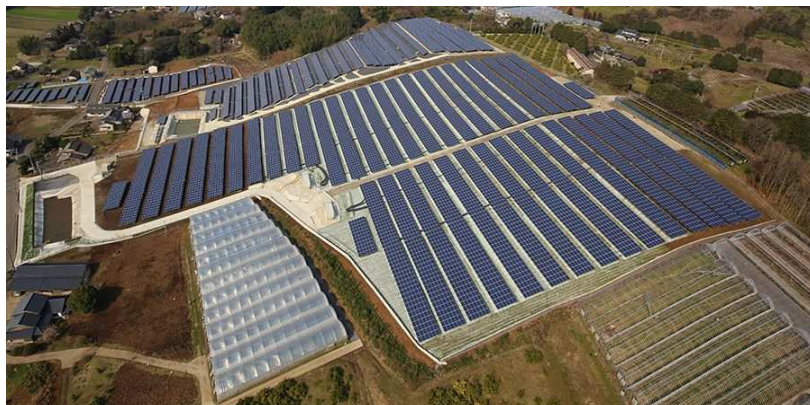
写真 6-6 里山を切り開いて建設されるメガソーラー発電所
